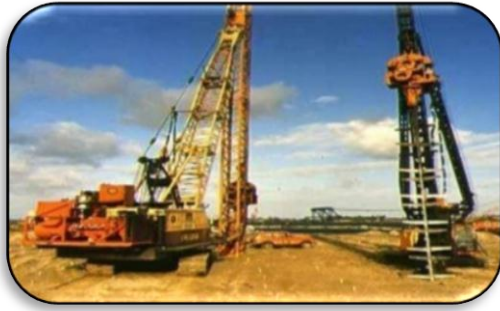
Figure I. 4 : Compactage par vitro-sonde.
