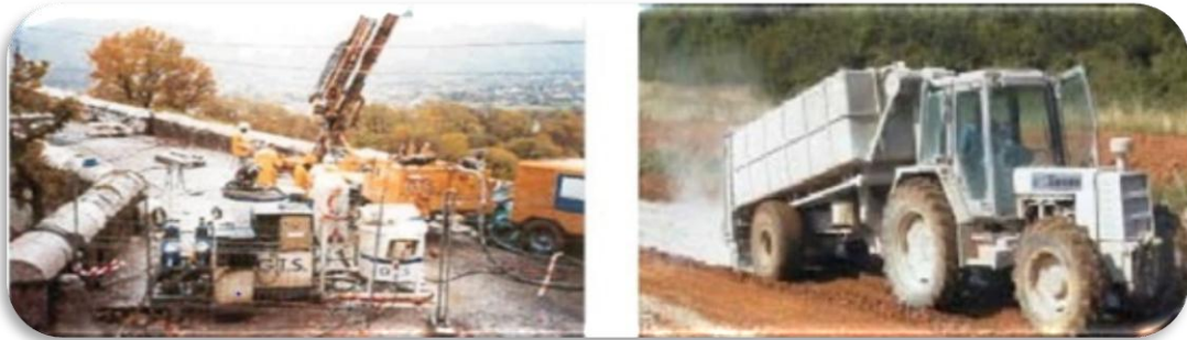
Figure I. 5 : Traitement chimique à la chaux et au ciment.
