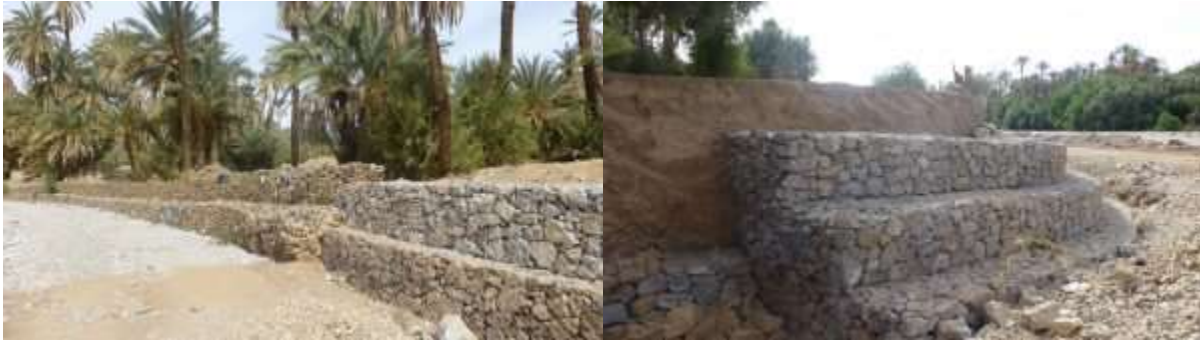
Image 11. Des gabions pour protéger les berges
