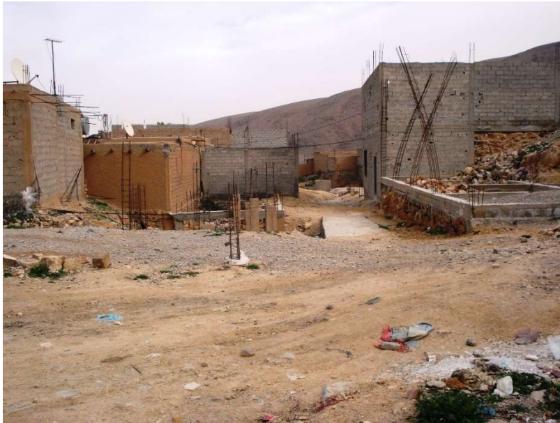
Image 8. Des nouvelles constructions d'habitat anarchique en cours de réalisation.
