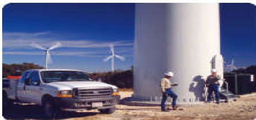
Figure I-6 : Tour d'une turbine.
