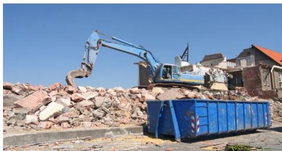
Figure 8: Déchets de démolition
