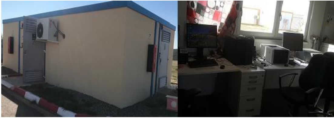
Figure II. 9: La salle de contrôle et de commande de la centrale PV Dhaya.
