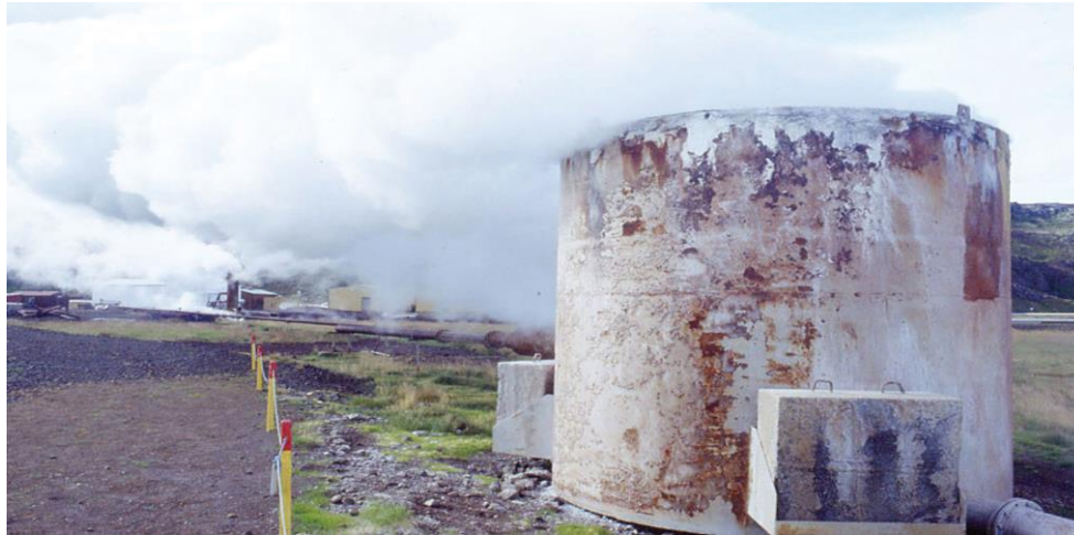
Figure 4. Centrale électrique en Islande (Canganella 2012).
