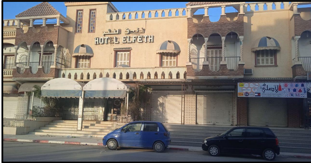
صورة 8: تمثل تجهيز خدماتي (فندق)
