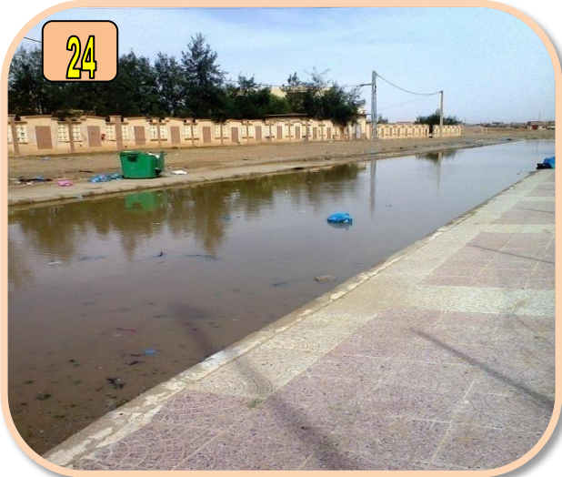
صورة تبين تجمع مياه الأمطار بسبب عدم أخذ الميل بعين الاعتبار
