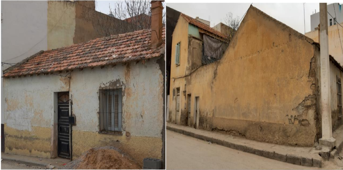
الصور 11-12: توضح طبيعة مواد البناء المصدر : الباحثة (مارس 2020)
