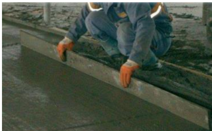
Figure II.4 : Mortier léger à base de noyaux d'olive.
