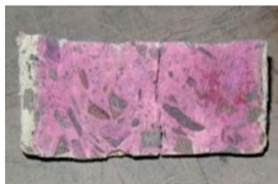
Figure 0-6 : phénomène de la carbonatation.[9]
