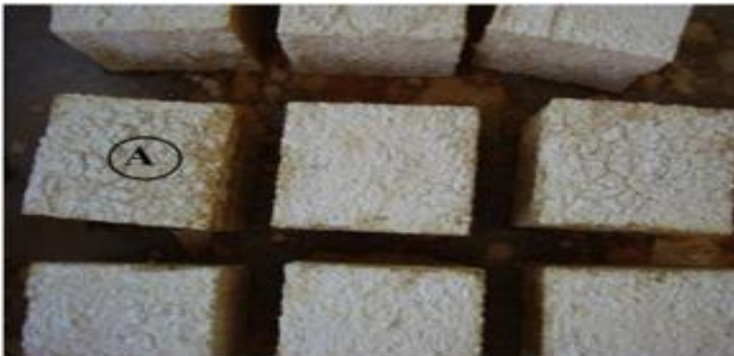
Figure 0-1 : Exemple de l'attaque par l'acide sulfurique dosé à 5% pour un béton ordinaire durant quatre mois [7]
