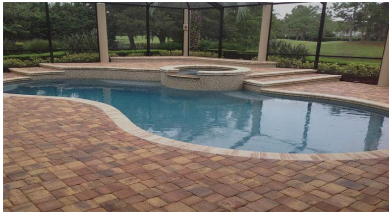
Fig.II.3.Aménagement au pavé en résine
