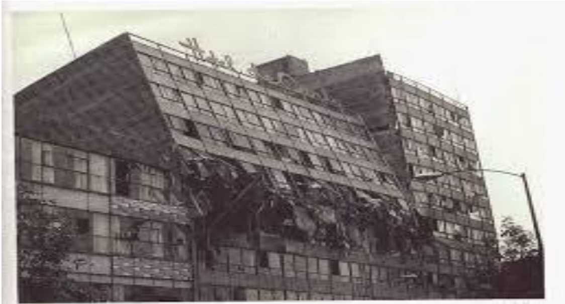
Fig.15 : Irrégularité en élévation
