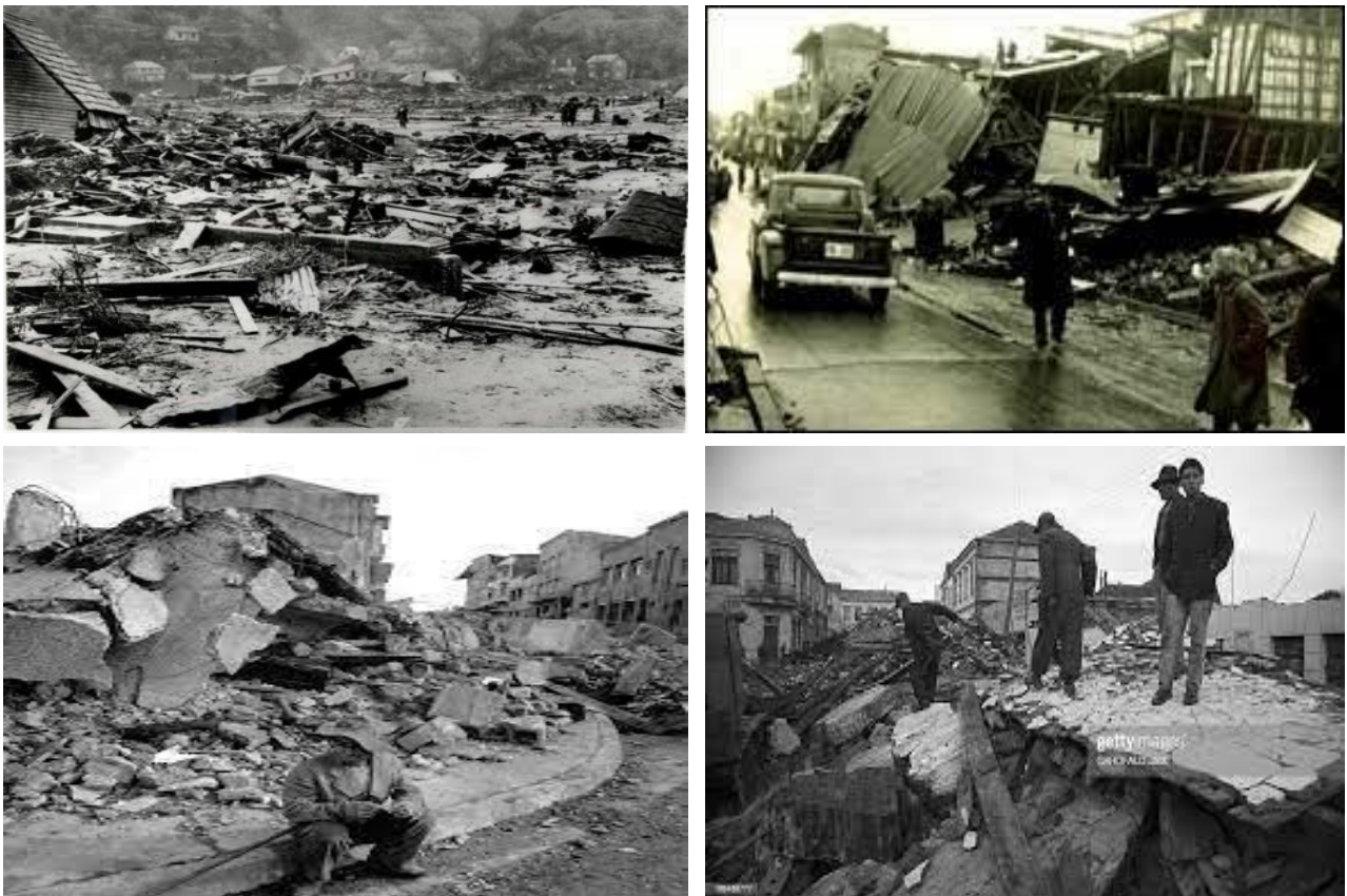
Fig.7 les dégâts du Séisme de Valdivia (Chili) en 1960 [13] [14]
