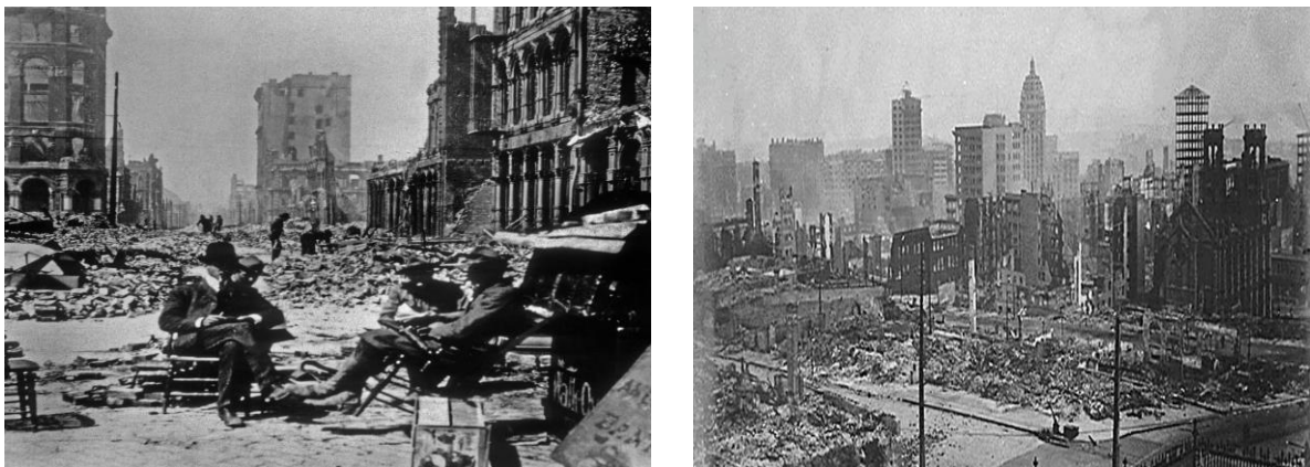
Fig12 : Séisme de San Francisco (États-Unis) en 1906 [19]
