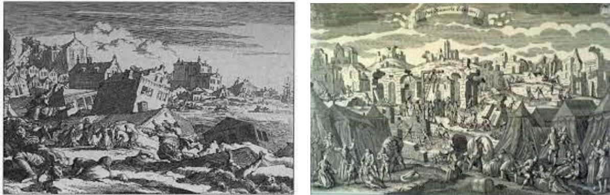
Fig.10 Séisme de Lisbonne (Portugal) en 1755 [17]
