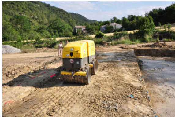
Figure IV.10 : Réduction des vibrations par utilisation d'engins téléguidés
