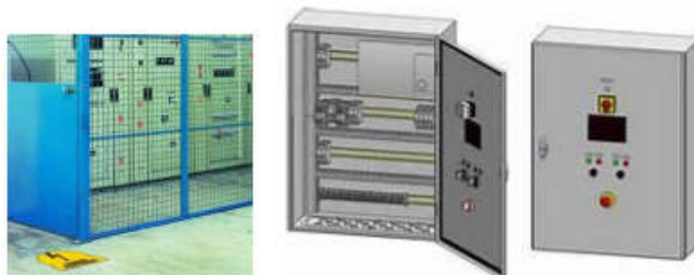
Figure III.29 : Protections permanentes par Grillage (a) et porte (b) d'armoire électrique
