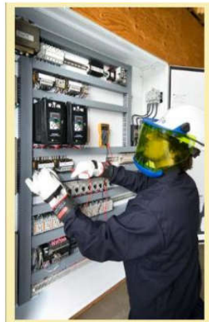
Figure III.19 Travail au contact : exemple pour la basse tension et la haute tension A
