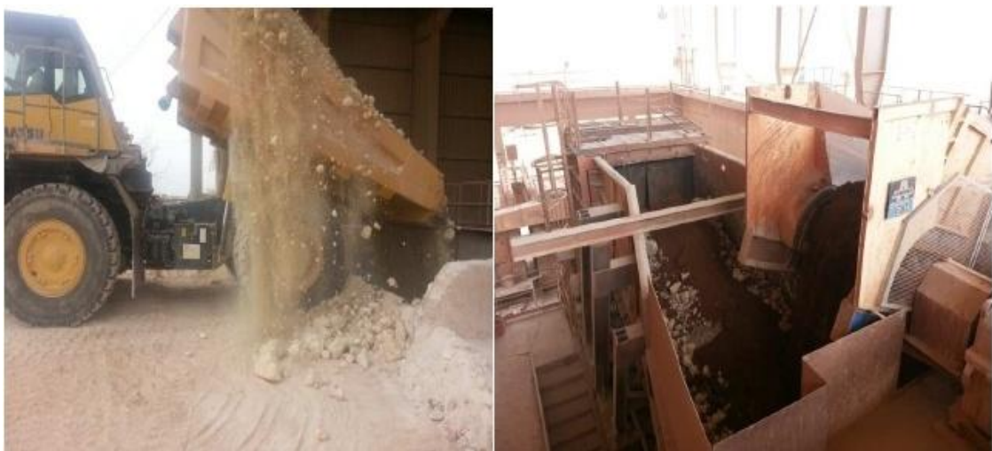
Figure I. 6: Concassage des matières premières au niveau de la carrière.
