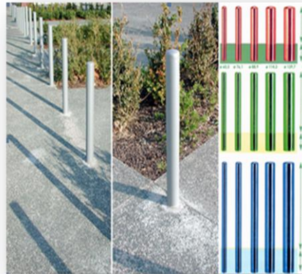
الصورة رقم (55):أعمدة الحماية.
