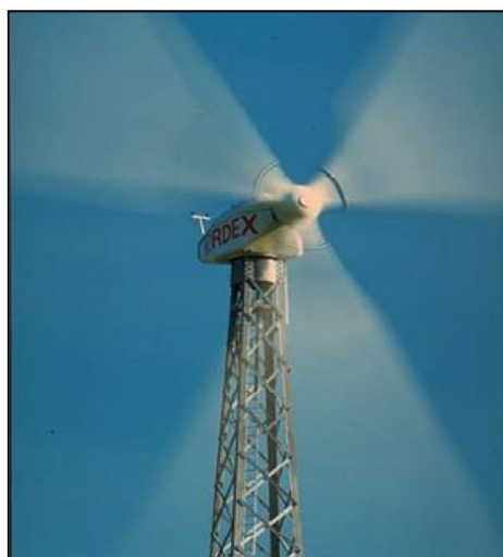
Fig. I.4. Pylône en treillis
