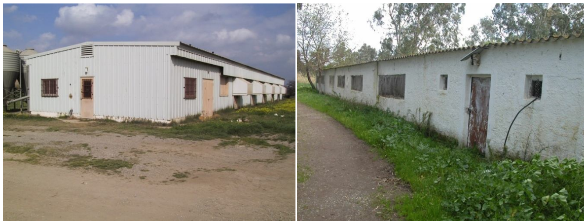
Figure 4: Bâtiment d'élevage de type obscur. Figure 5: Bâtiment d'élevage de type clair.
