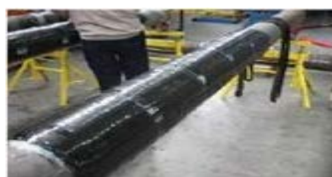
Figure II.13: (a) Installation de la moitié de la coquille du composite en carbone, (b) réparation finale
