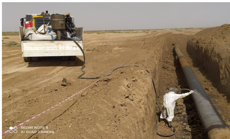
Figure II. 09 : Opération de sablage du pipe en exploitation
