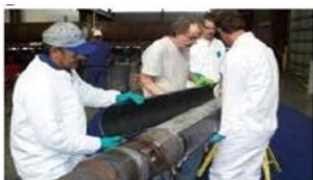
Figure II.13: (a) Installation de la moitié de la coquille du composite en carbone, (b) réparation finale
