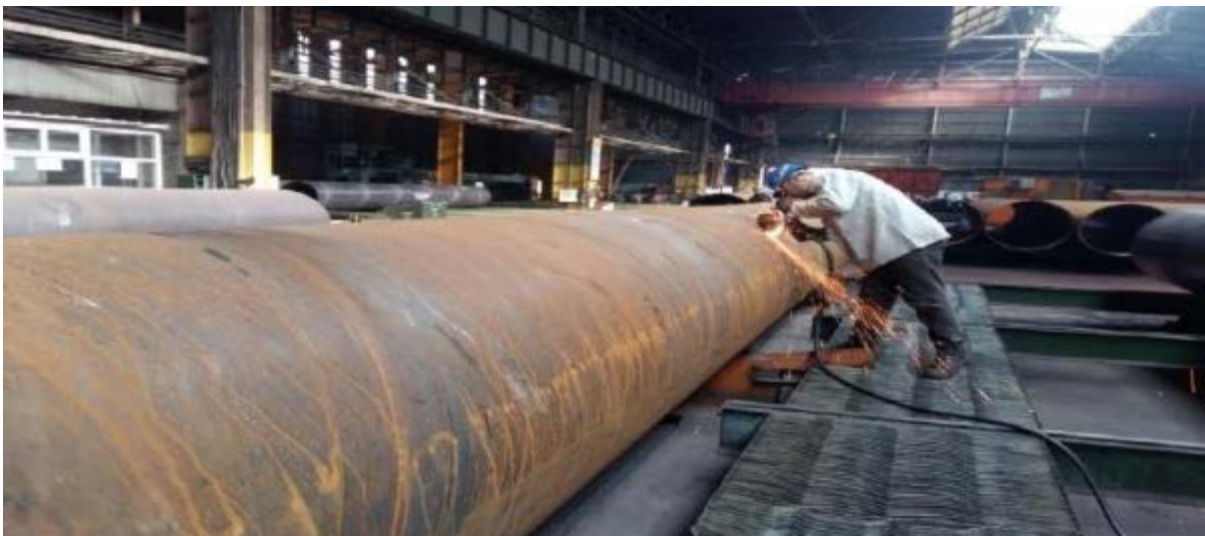
Figure I. 04: Réparation des défauts manuellement. [3]
