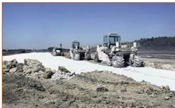
Figure (I-14) : Traitement par la chaux.
