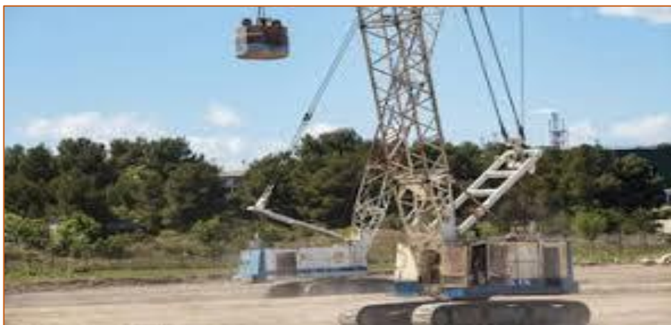
Figure( I.13)Compactage dynamique.
