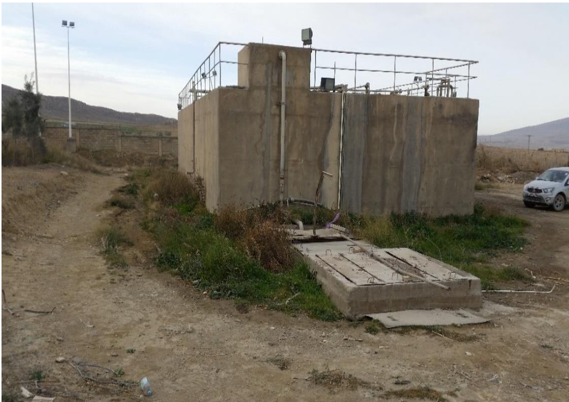
Figure 20 : Station de traitement des eaux usées de la cimenterie LCM (GHALIA.S. LAIFA.A, 2023).
