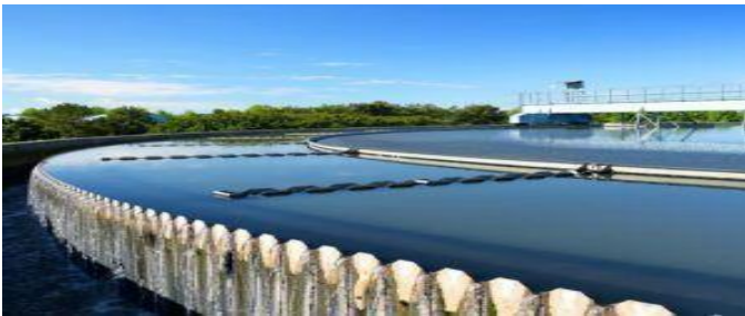
Figure N° 3 : bassin de traitements secondaires
