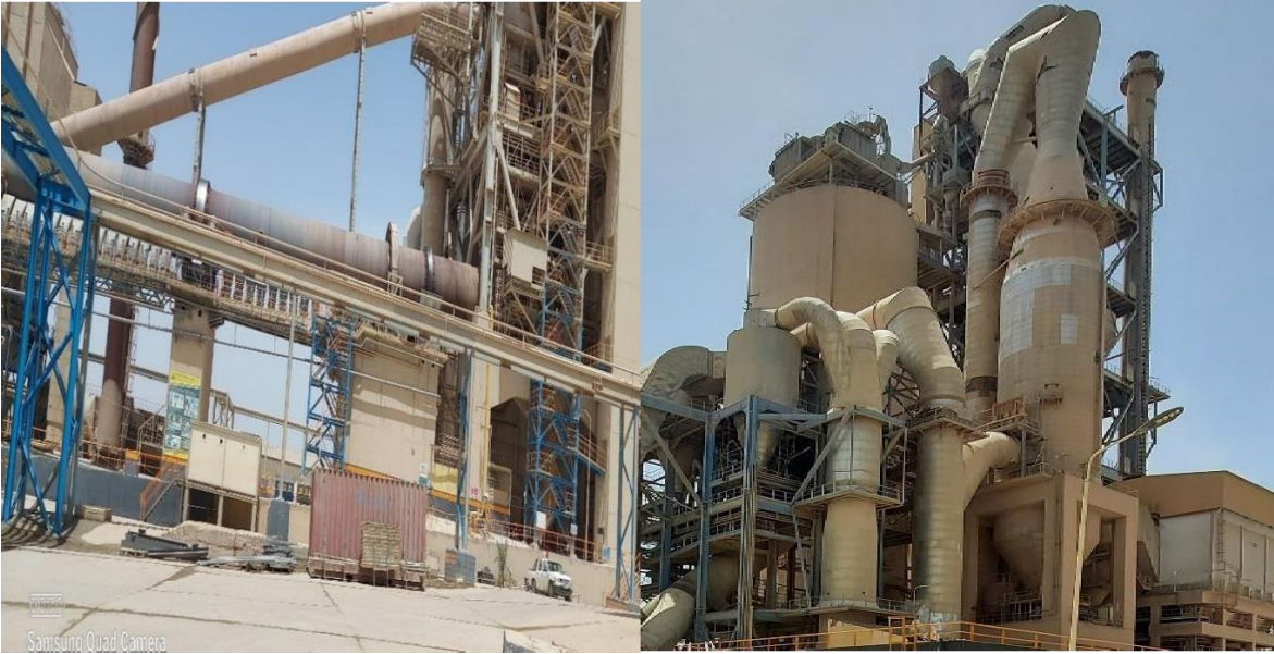
Figure N°11 : Four rotatif et tours de préchauffage. (GHALIA.S. LAIFA.A, 2023)
