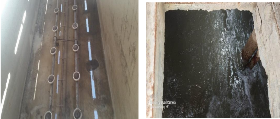
Figure N°25 : bassin d'aération (GHALIA.S. LAIFA.A, 2023)
