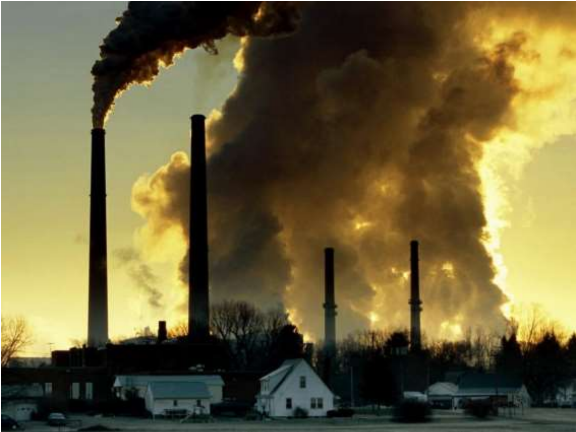
صورة : مثال عن تلوث الهواء - المصدر: مقال التلوث البيئي أسباب ومخاطر وحلول، المرجع المذكور أعلاه.
