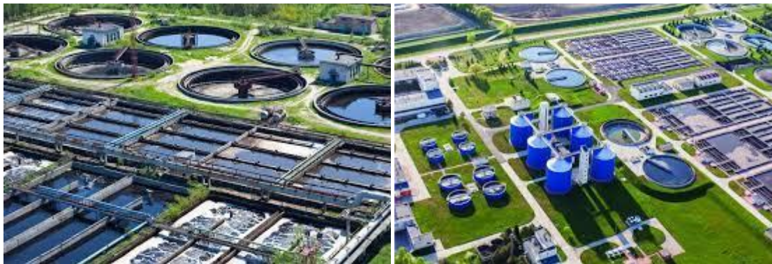
Figure I. 2: Une station d'épuration des eaux usées.
