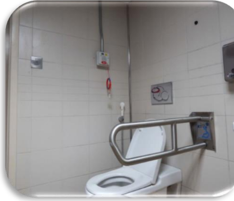
الصورة رقم 15 : يوضح شكل دورة المياه
