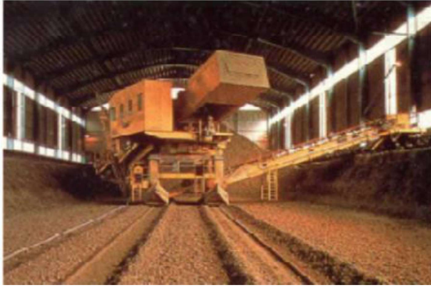
Figure 1-7 : Hall de préhomogénéisation [11]
