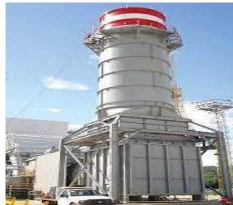
Figure I.8: Corps d'un Echappement d'une Turbine à Gaz
