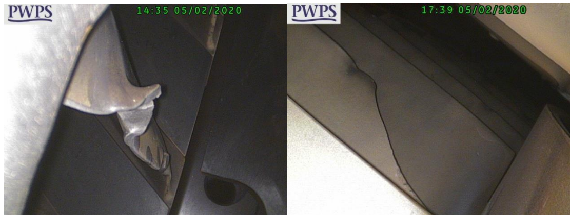
Figure I.17: Défaillance des aubes compresseur (TAG V94.3A de M'sila)
