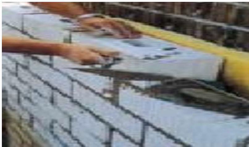
Figure V-2: Mur en brique silico-calcaire.
