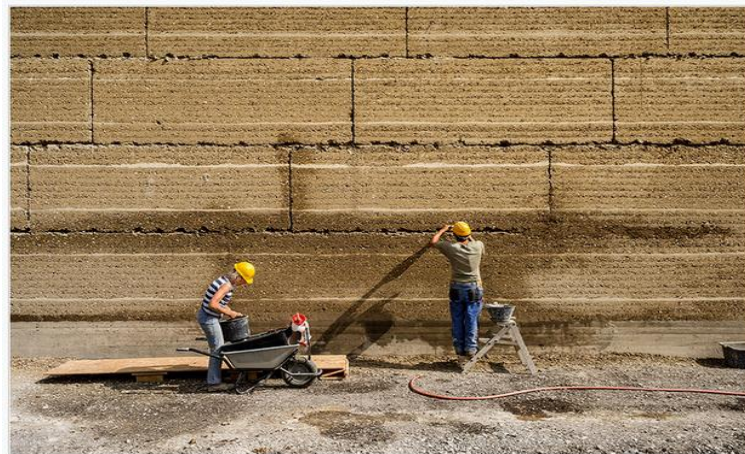
Figure IV-3: La construction en pisé.
