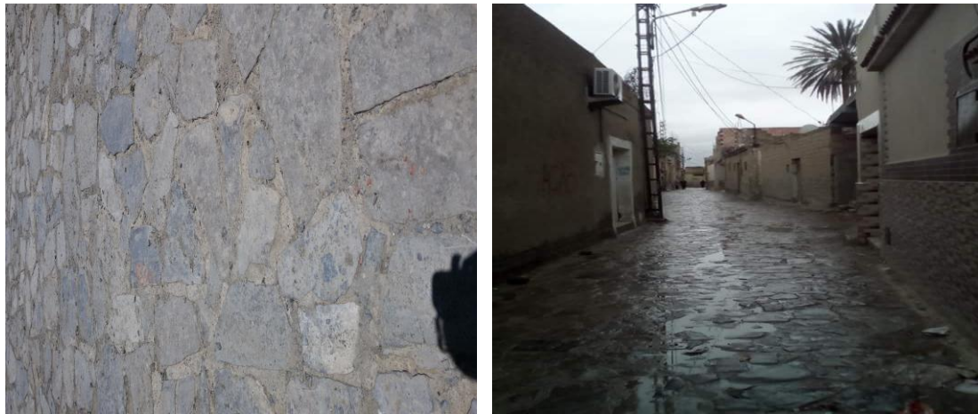
Figure VI-5: revêtements de sol : rues d'ancien cité « L'Aargoub - m'sila- ».
