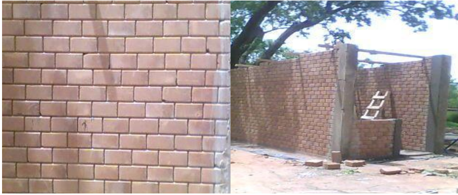
Figure IV-12: Murs en bloc de terre comprimée.
