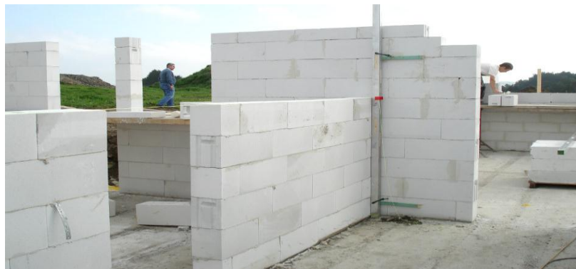
Figure V-5: La maçonnerie (murs) en Siporex.
