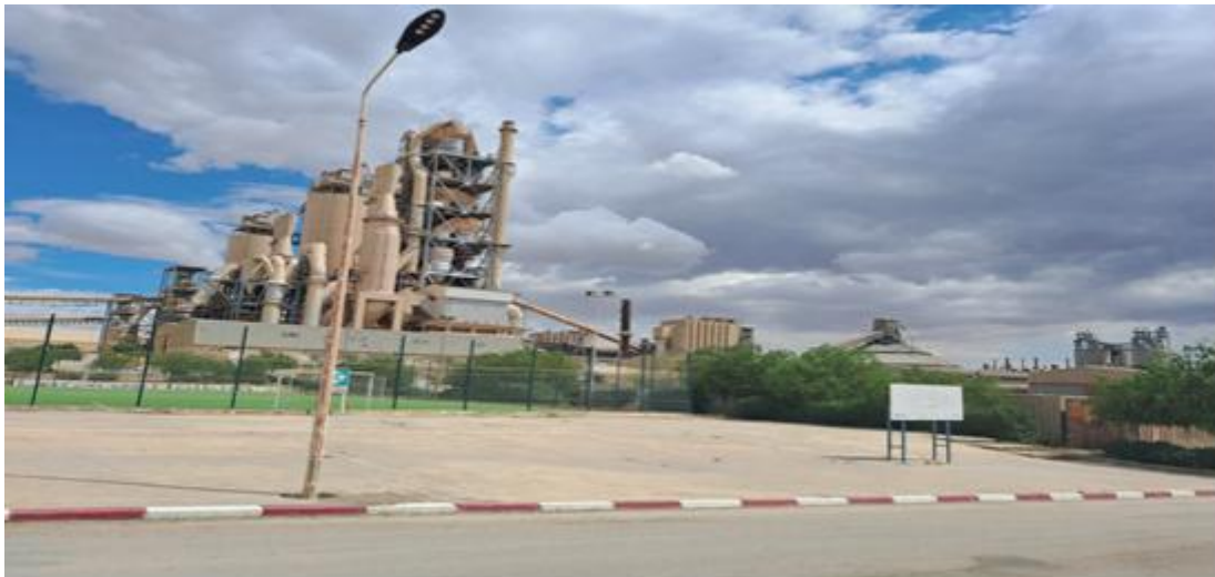
FIGURE I. 5: STADE DE SPORT A L'INTERIEUR DE LA CIMENTERIE LCM
