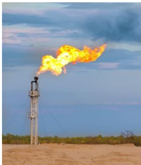
Figure (I.2) : Torches de brûlage de puits de Pétrole
