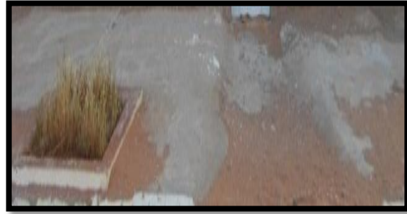
الصورة(71): الارصفة قبل التدخل
