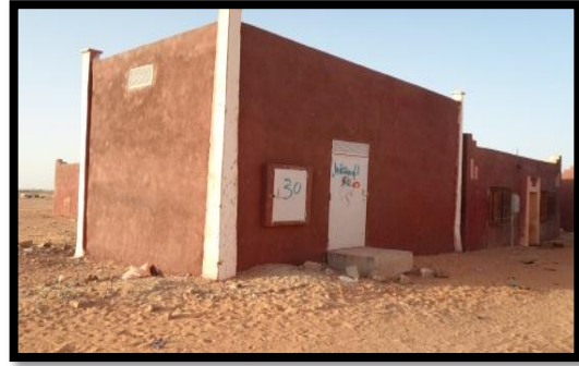
صورة (60): محول كهربائي
