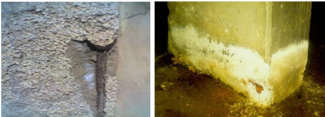
Figure 1.11 : attaques sulfatiques (IHAB, 2015/2016)
