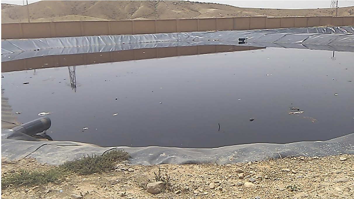
Figure 16 : Bassin de collecte du Lixiviat de la CET de M'sila (photo 17/05/2021).
