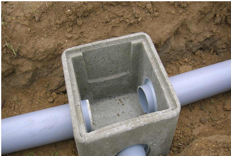
Figure I.8 : Boîte de branchement eaux usées
