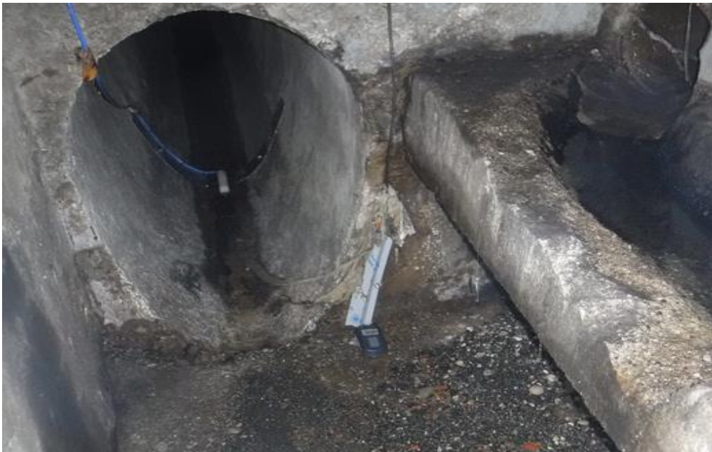
Figure I.9 : Un déversoir d'orage
