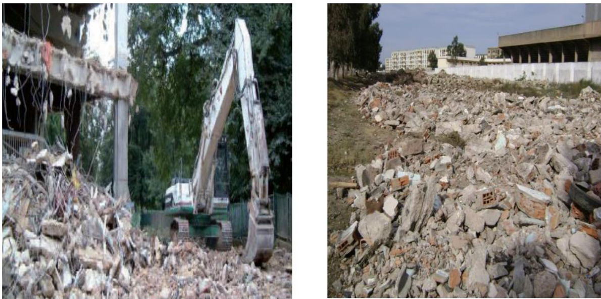
Fig. II. 6 Les déchets de chantier [29]
