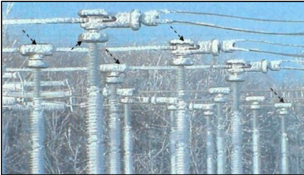
Figure. III. 6. Isolateurs semi-conducteurs de poste 500 KV, équipés d'anneau de garde dans des conditions givrage en Virginie [61].
