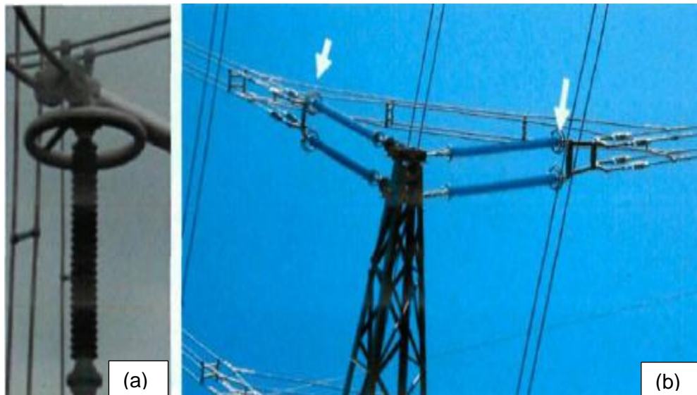
Figure. III. 5. Exemples d'utilisation des anneaux de garde sur un isolateur de poste (a) et un isolateur de ligne en composite (b) [51].
