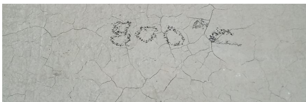
Figure (IV.24) : micro fissures apparents sur la surface d'une éprouvette chauffée à 800°C .
