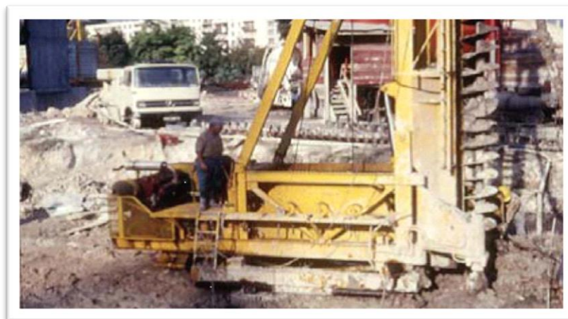
Figure -1.14- Schéma de la tarière creuse
