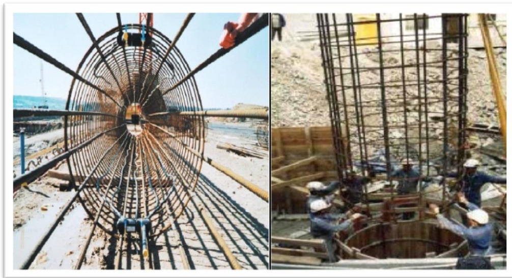
Figure -1.22- Schéma de ferrailage d'un pieu foré avec un tubage
