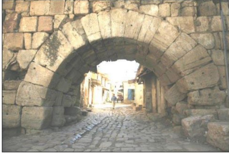
الصورة 9 المدخل الرئيسي باب البلد
