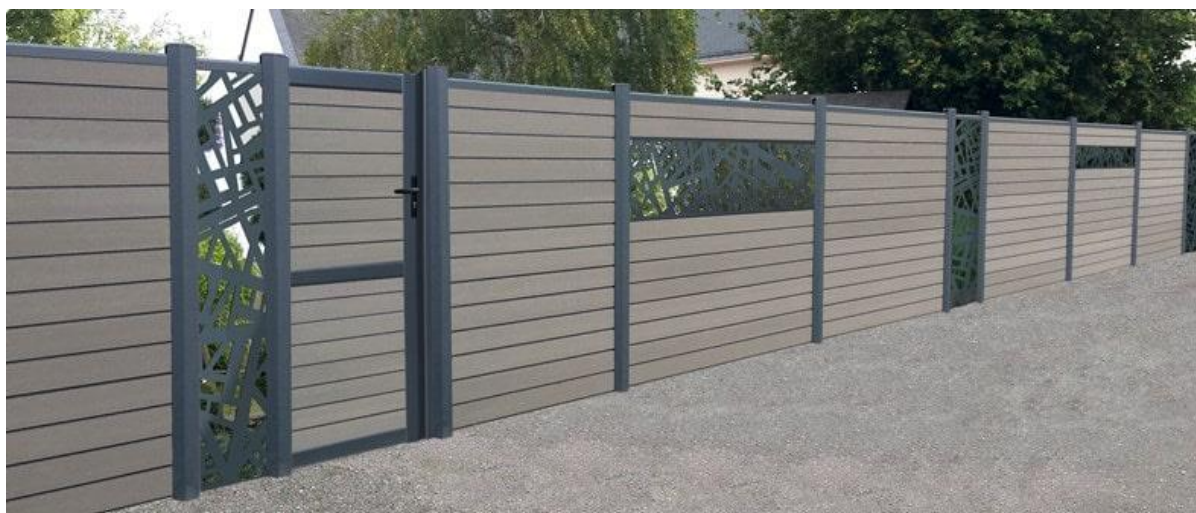
FIG I.18 :Clôture En composite
