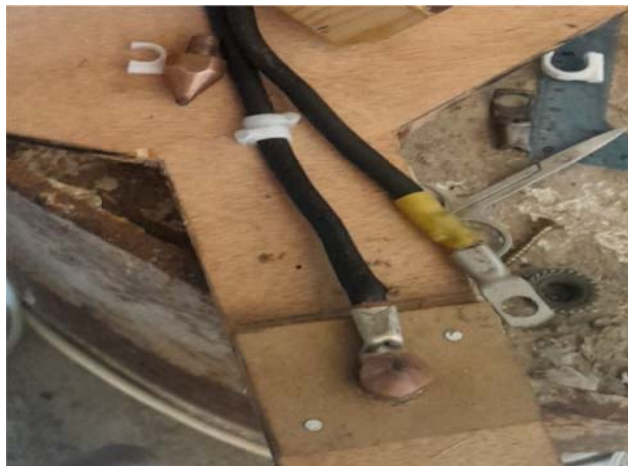
(Fig. III. 18) : Installation de Électrodes.
