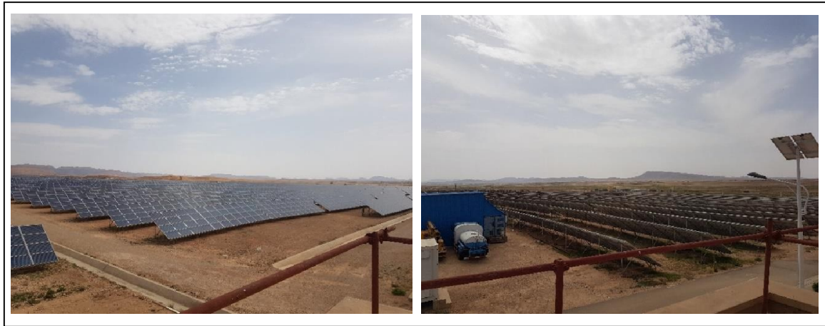
Figure II.18. Photos aériennes de la centrale photovoltaïque de Aine El-Melh.
