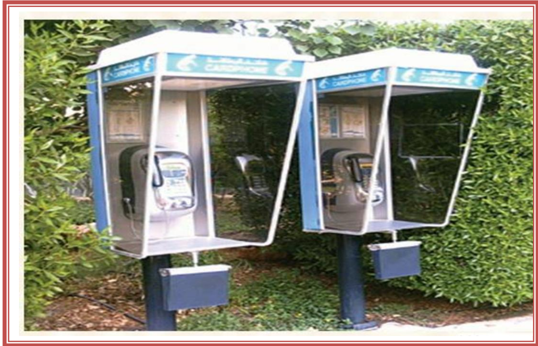
الصورة رقم: 103 كباتن الهاتف
