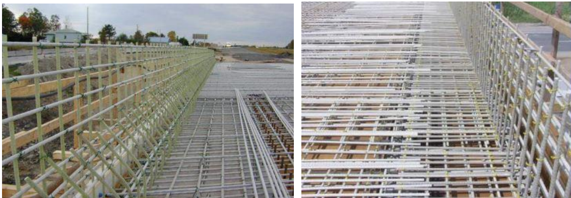
Figure II-13 : Murs de barrière de pont [18].
