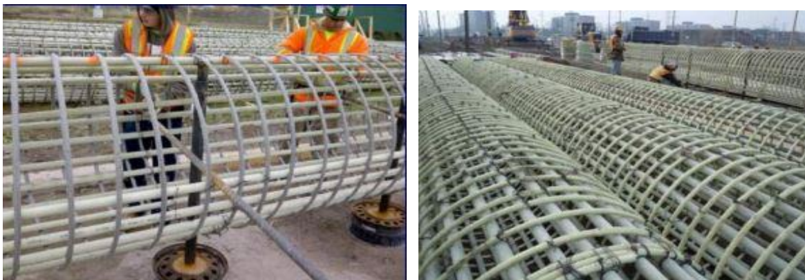
Figure II-11 : L'armature PRF d'un Tunnel en PRF [18].
