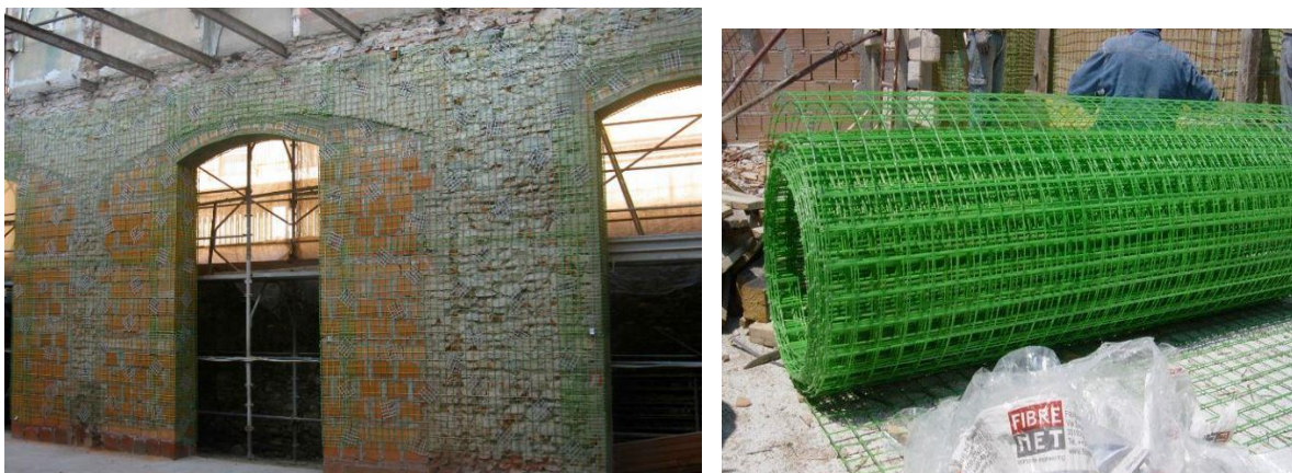
Figure II-16 : Treillis de renfort en PRF de maçonneries [19].
