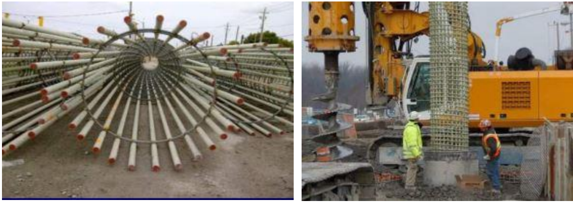
Figure II-12 : Poser l'armature PRF d'un Tunnel [18].
