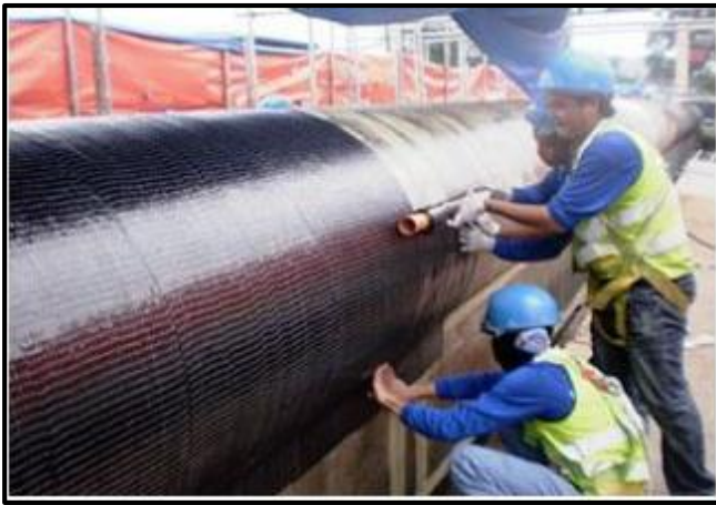
Figure I-11 : Réparation des conduites par matériaux composites [07].
