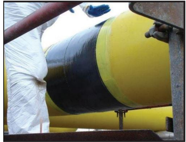
Figure I-11 : Réparation des conduites par matériaux composites [07].
