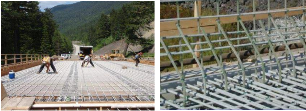
Figure II-08 : Dalles de tablier de pont [18].
