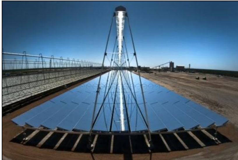
Fig. I.9 : Centrale solaire à miroir de Fresnel [22].
