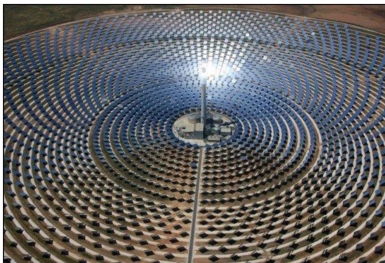
Fig. I.13 : Centrale solaire à tour [25].
