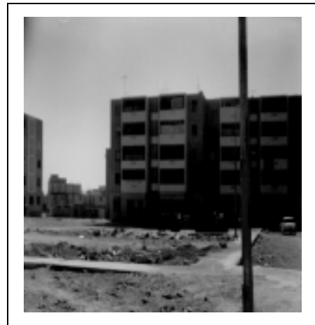
Photo III. 11 éparpillement des déchets(500logements)
