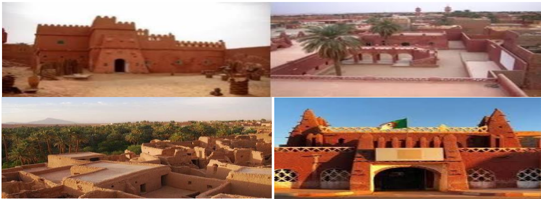
Figure _I 3 : Constructions en blocs de terre la région Qourara.
