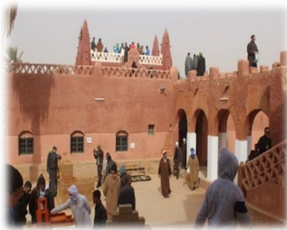
Figure I.17 : Atelier d'initiation aux techniques de construction en terre. Timimoun
