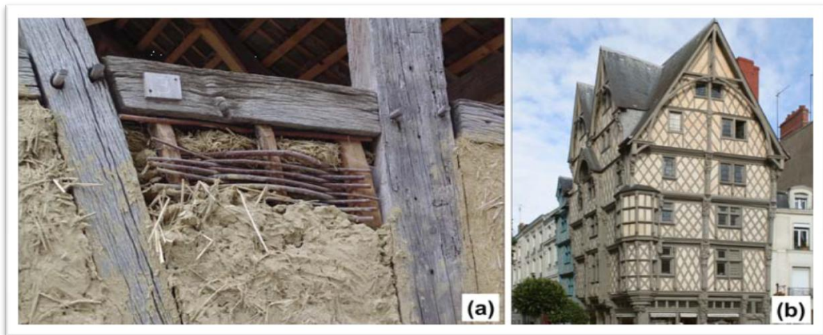
Figure I.10 : (a) La technique du torchis illustrée ; (b) Une construction en torchis à Angers, France.
