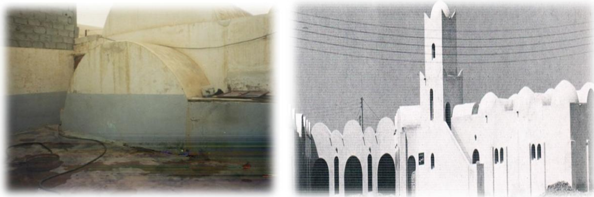
Figure I.19 : Nouveau village agricole de Maadher, près de M'sila en Algérie construit en parpaings de terre stabilisée en 1980 par deux architectes, les frères El Miniaway.
