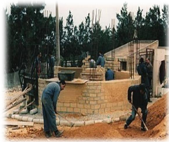
Figure I.18 : Premières assises du Prototype de Souidania 1999 (LE CNERIB)
