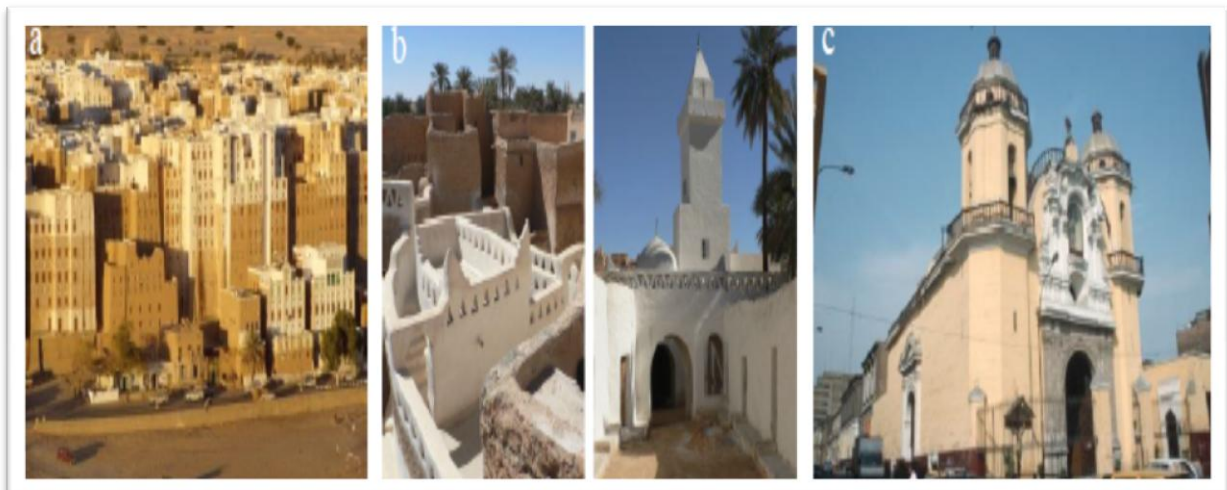
Figure I.7 : Constructions en adobe : Shibam, Yémen ; Ghadamès, Libye ; Lima, Pérou
