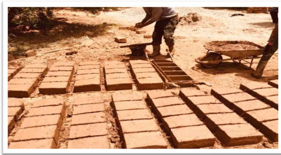
Figure I.4 : Moulage et séchage des blocs adobes
