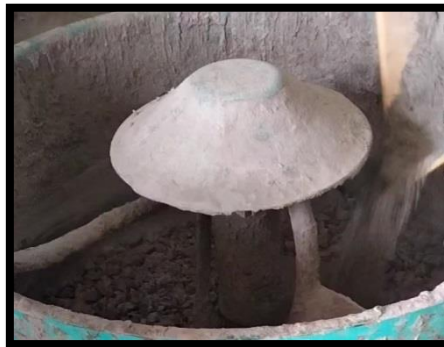
Figure III.6. Malaxage du béton
