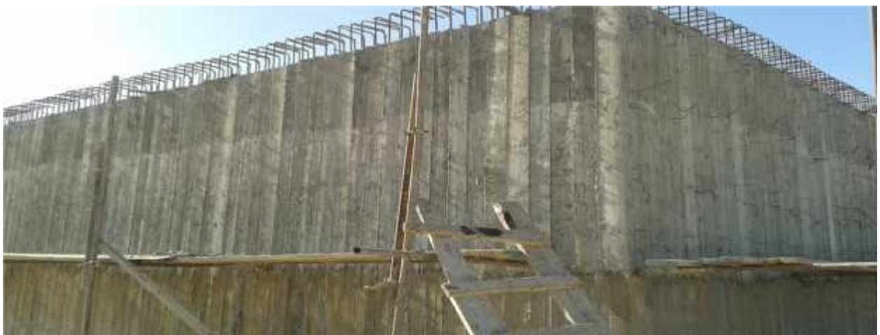
Figure.V.4: la cuve en béton armé
