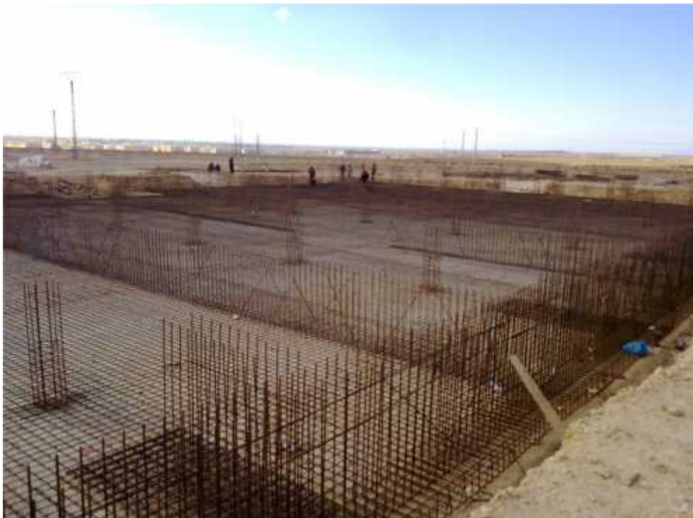
Figure VI.2 : La main d'œuvre à l'étape de ferraillage
