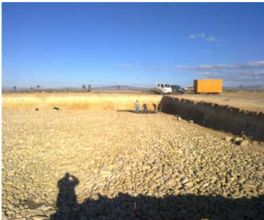
Figure VI.4 : La main d'œuvre a l'étape de bétonnage
