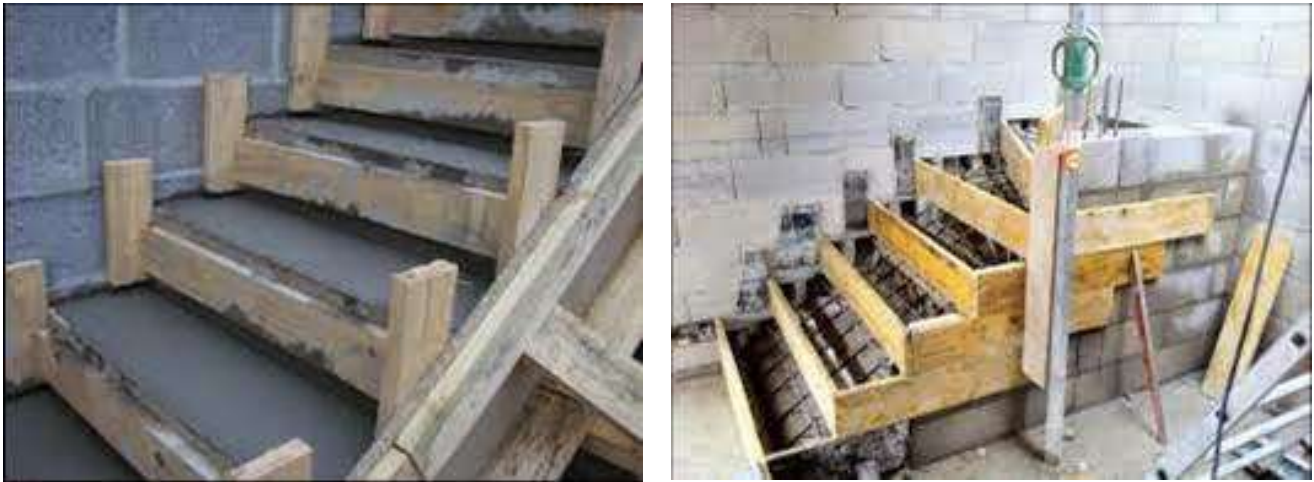
FigureII9 : Les escaliers en béton
